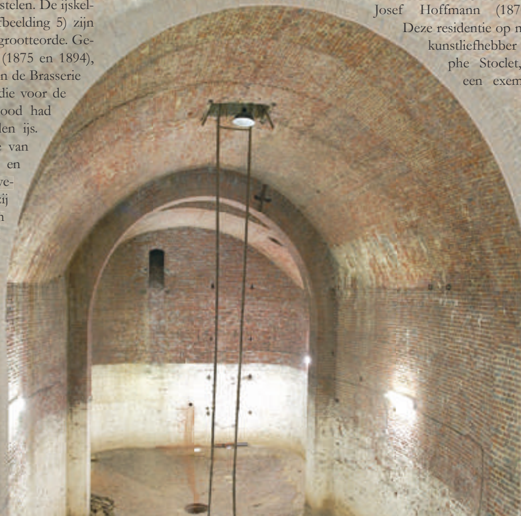
Afbeelding 5: Ijskelders van Oudergem. Zicht op de oudste ijskelder (1875). © KIK-IRPA, Brussel
