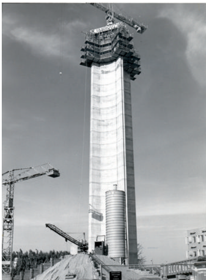
Omroepcentrum Reyerslaan, toren in aanbouw (1981) (Fotoarchief VRT)
