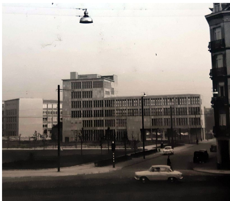
Rue des Goujons dans les années 1950 (Administration communale d'Anderlecht)
