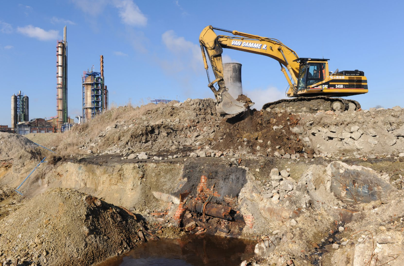
Les terres polluées sont majoritairement excavées, une solution qui ne répond pas aux enjeux de la Région. © Archives de l'État
