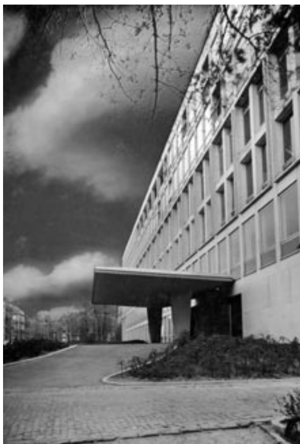
Façade avant de l'Institut royal du patrimoine artistique, Charles Rimanque (architecte), 1958-1962.
