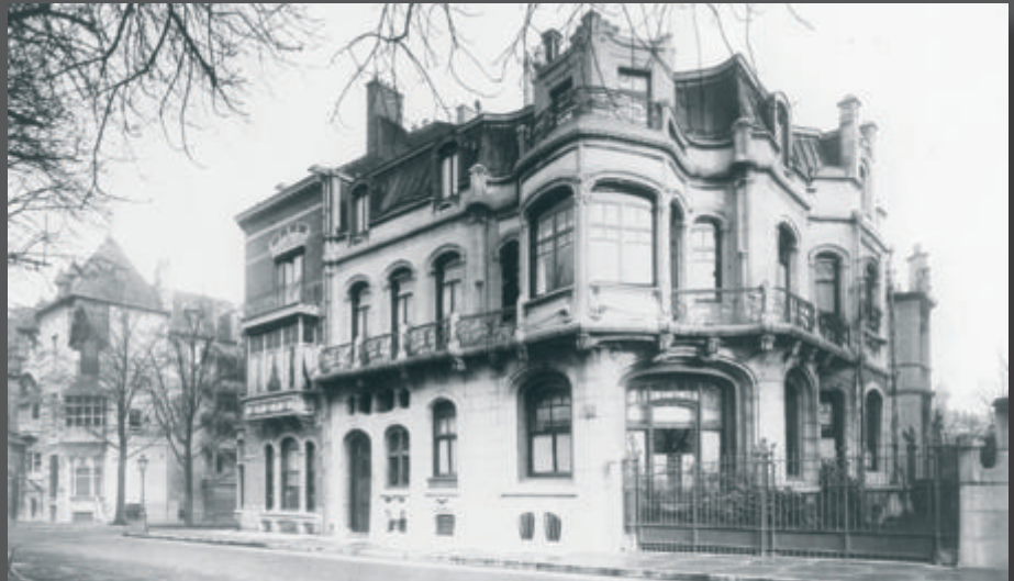
Gevel van het voormalige Hotel Aubecq © Hortamuseum
