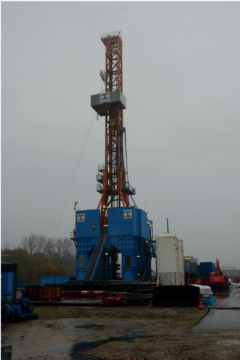
De 60 meter hoge boortoren op de Balmatt-site in Mol, waar het proefproject van VITO plaatsvindt. © KBIN
