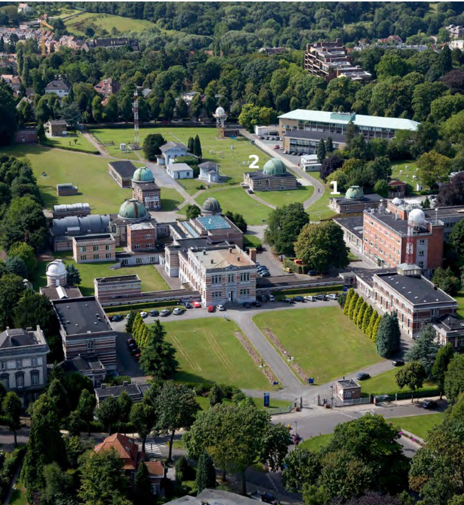
Vue aérienne du site d'Uccle avec les coupoles du Double Astrographe (1) et du Télescope Schmidt (2). © Régie des Bâtiments
