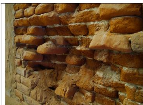
Figure 1. Exemple de dégâts causés par les sels dans une maçonnerie historique (Photo KIK-IRPA, Hof te Bree-Eijk à Lennik, Belgique)
