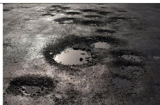
Figure 2. Exemple de dégâts causés par les sels sur les routes et les ponts (Photo via Shutterstock)
