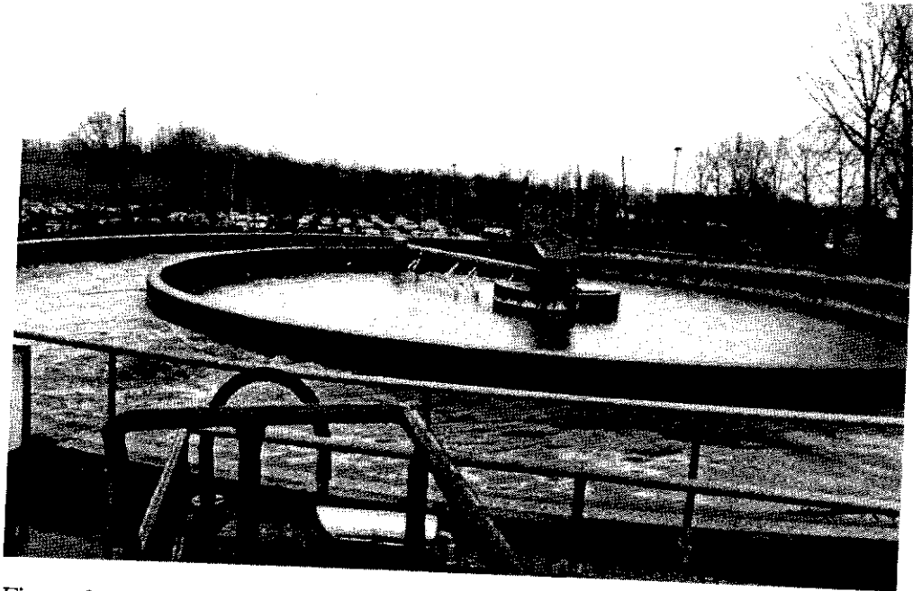
Figure 3: Station d'épuration des eaux usées de l'hôpital Erasme à Bruxelles (Débit journalier moyen: 700 m 3 ). Boues activées.
