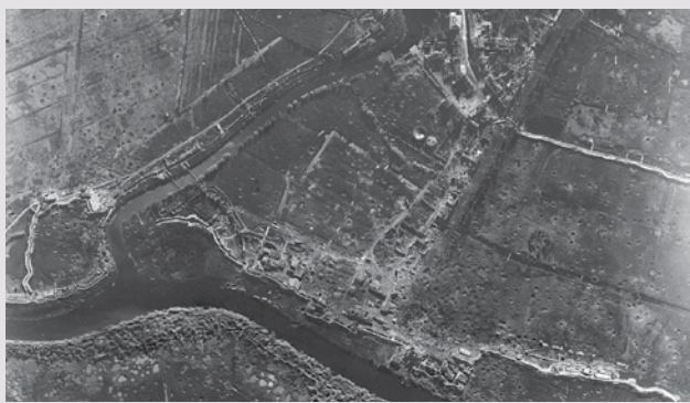
Luchtfoto van de loopgraven en verwoestingen aan de 'Bloemmolen' in Diksmuide (Brussel, ARA, Fotoverzameling Commissie voor oorlogsarchieven)
