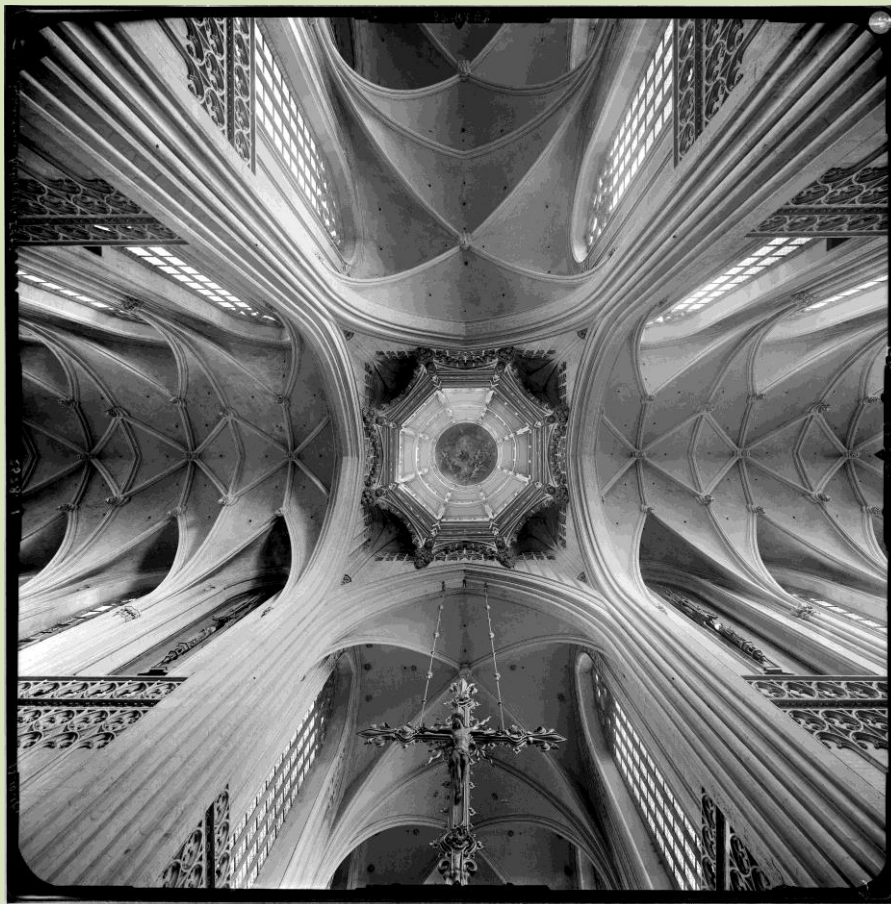
Fig. 4 : Coupole de la cathédrale Notre-Dame d'Anvers, photographiée le 13 octobre 1917 par l'Institut de Photogrammétrie de Berlin, dirigé par Theodor von Lüpke. Le photographe a basculé la chambre technique grâce à un dispositif articulé vissé entre le trépied et l'appareil. Cette vue époustouflante de la voûte est parfaitement centrée : les marques fiduciaires du châssis (marques de repère) ont permis à l'opérateur de vérifier le positionnement exact au centre de la croisée du transept. © KIK-IRPA, Bruxelles, 1917, F000036.
