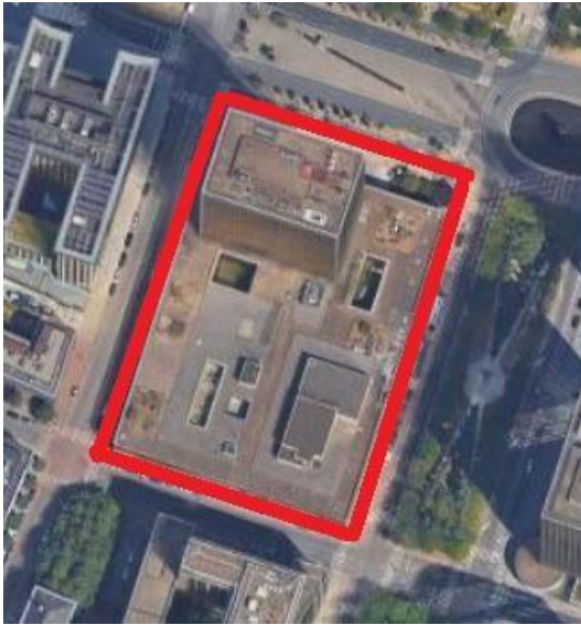
Perceel dat het WTC III-gebouw omvat
