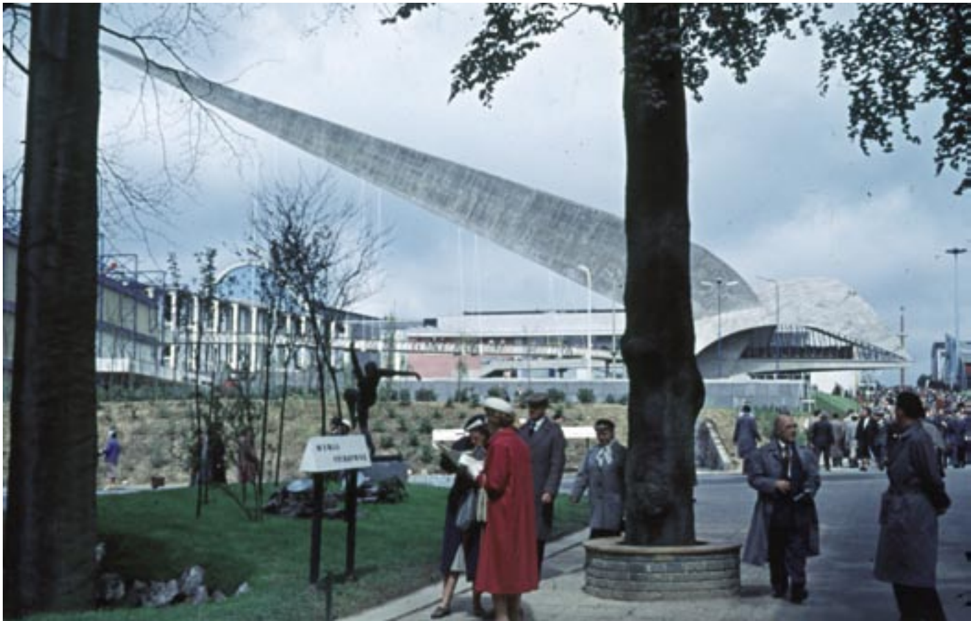
De pijl van de Burgerlijke Bouwkunde: een overhangende constructie van gewapend beton van 4 tot 12 cm dik en 80 meter lang die 36 meter boven de grond zweefde. Temploux, Collectie A. Stevelinck.
