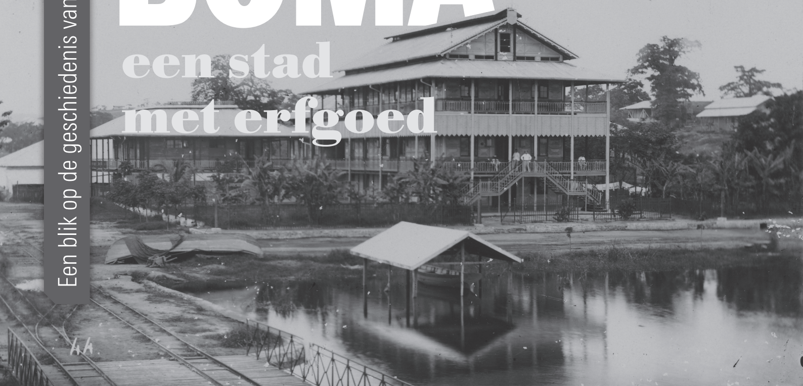
Het voormalige hotel van de Société des magasins généraux te Boma. Foto toegeschreven aan H. A. Shanu, vermoedelijk 1896. Collectie KMMA, AP.O.0.44
